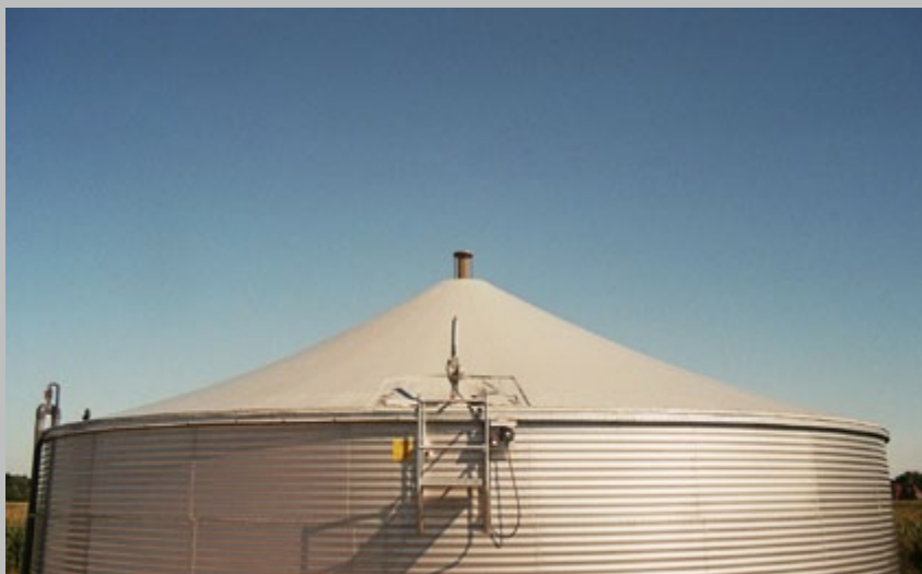
Вид емкости с наружи с пленочной крышей Widok zewnętrzny zbiornika z dachem z folii
