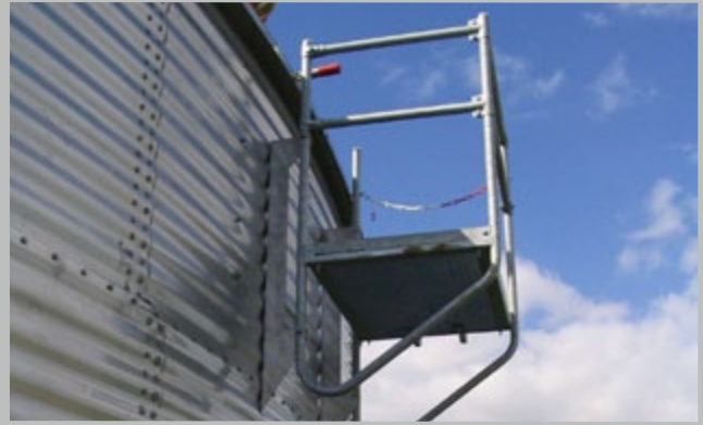
Рабочая площадка на емкости из нержавеющей стали Podest przy zbiorniku ze stali szlachetnej
