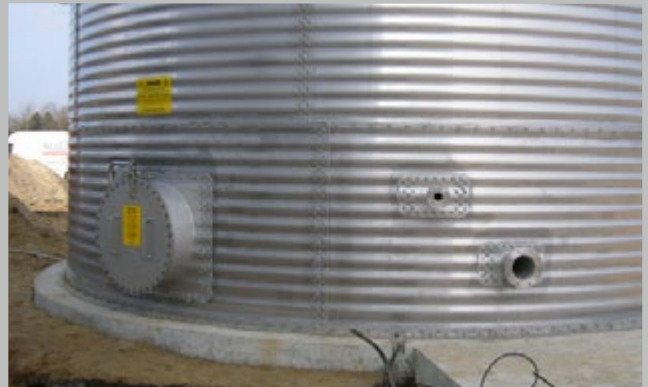
Люк DN800 с поворотной консолью Właz DN800 z ramieniem uchylnym
