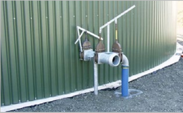
Заборная станция на емкости с изоляцией System opróżniania w izolowanym zbiorniku
