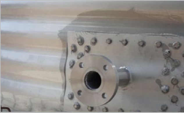
Проем в стенке Przepust w ścianie
