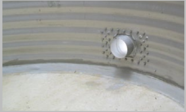
Уплотнение дна в емкости Uszczelnienie ścian zbiornika przy płycie żelbetowej
