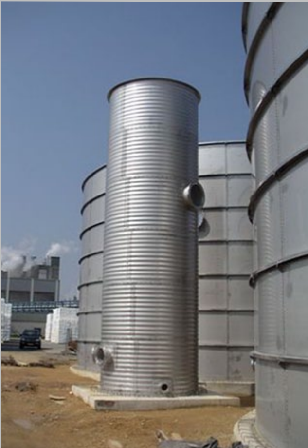
Компенсационная емкость заводской очистной станции Zbiornik wyrównawczy w przemysłowej oczyszczalni ścieków
